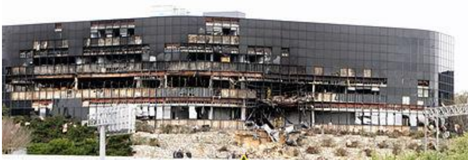
Рис. 3. В результате прямого попадания самолета малой авиации Piper Dakota в 4-х этажное железобетонное здание делового назначения (здание 1 офисного комплекса «Эшелон») в г. Остин, штат Техас 18 февраля 2010 года и возникшего пожара здание полностью выгорело [10].
