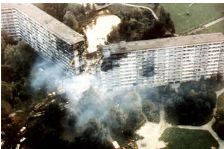
Рис. 4. Результат прямого попадания (с отвесного пикирования) грузового самолета Boeing 747 в жилой дом, расположенный в 13 км от а/п г. Амстердам «Схипхол», 4 октября 1992 года. В месте попадания разрушены все 11 этажей железобетонного здания и нарушена целостность несущих конструкций здания в целом. Дальнейшим расследованием доказано, что наряду со 150 тоннами авиакеросина на борту Boeing находились боеприпасы, взрывчатые вещества, 190 литров отравляющего вещества диметил-метилфосфоната и 1000 литров трибутилфосфата.
